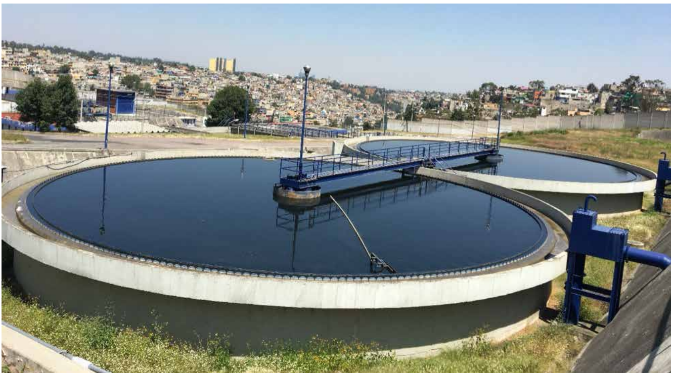
Planta de tratamiento de aguas residuales Cerro de la Estrella en Iztapalapa
