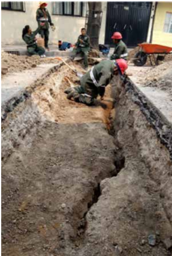
Trabajos para la mitigación de grietas en la Ciudad de México
