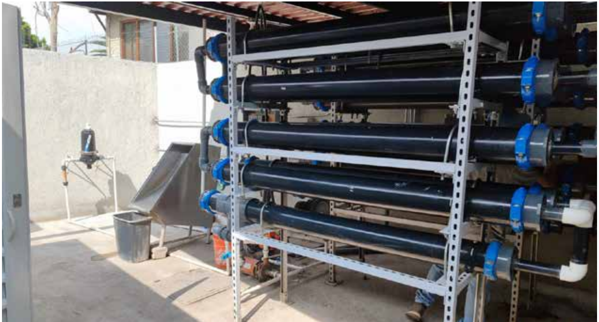
Sistema descentralizado de tratamiento de aguas residuales, ubicado en el barrio de San Lorenzo Xochimilco
