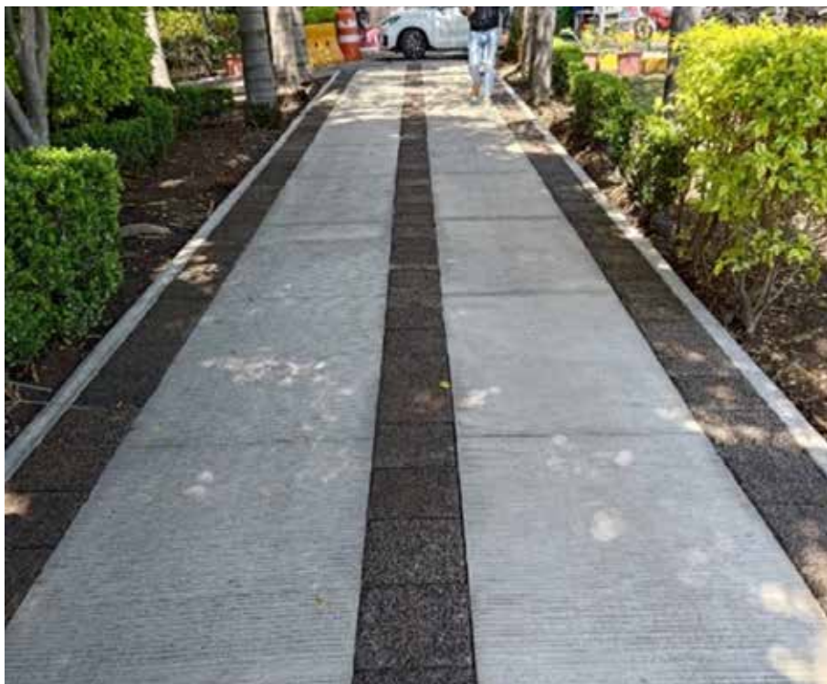
Se produjeron concretos permeables e impermeables utilizando resina insaturada con nanopartículas y granulados de concreto reciclado
